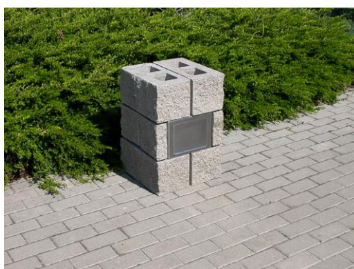
krok 6 – vybírací otvor
